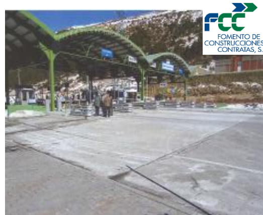
Peaje Túnel D' Envalira Reparación pavimento
